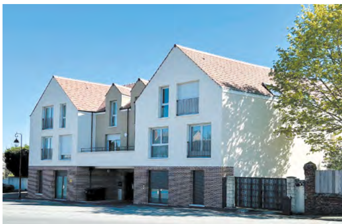
La résidence Alix Aymé à Warluis est composée de 11 logements et de 2 locaux professionnels.
