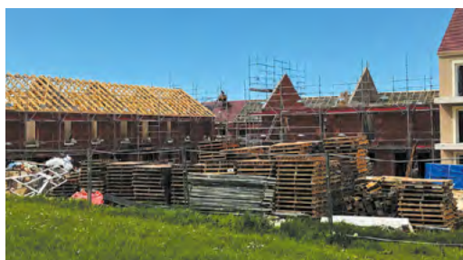
Lancement du chantier de la résidence du Clos Folie à Beauvais
