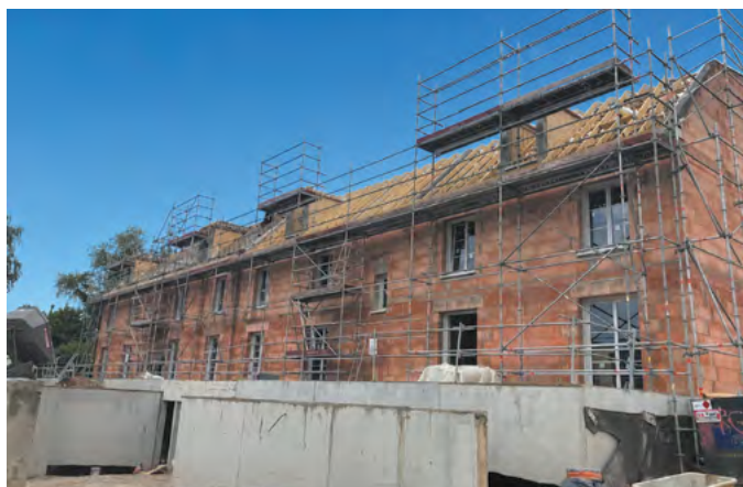
À Méru (achat en VEFA) a été lancé le chantier d'une résidence composée de 34 logements dont 26 en bâtiments collectifs et 8 maisons individuelles. La réception est prévue en juin 2027.
